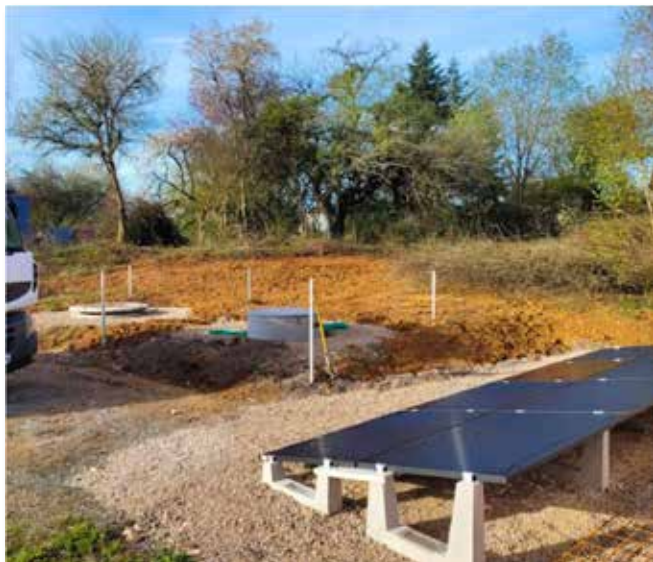
Volant en béton sous-compression de fibres / Volant de stockage en place dans le sol et sa ferme solaire
